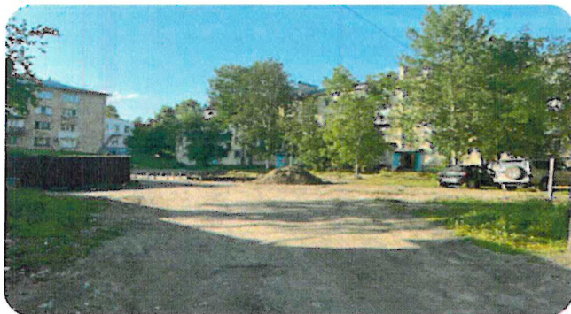
Фото до начала работ
