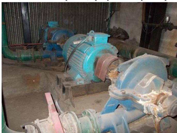
Рисунок 3.1.52 – Сетевые насосы Д320-50, 75 кВт
