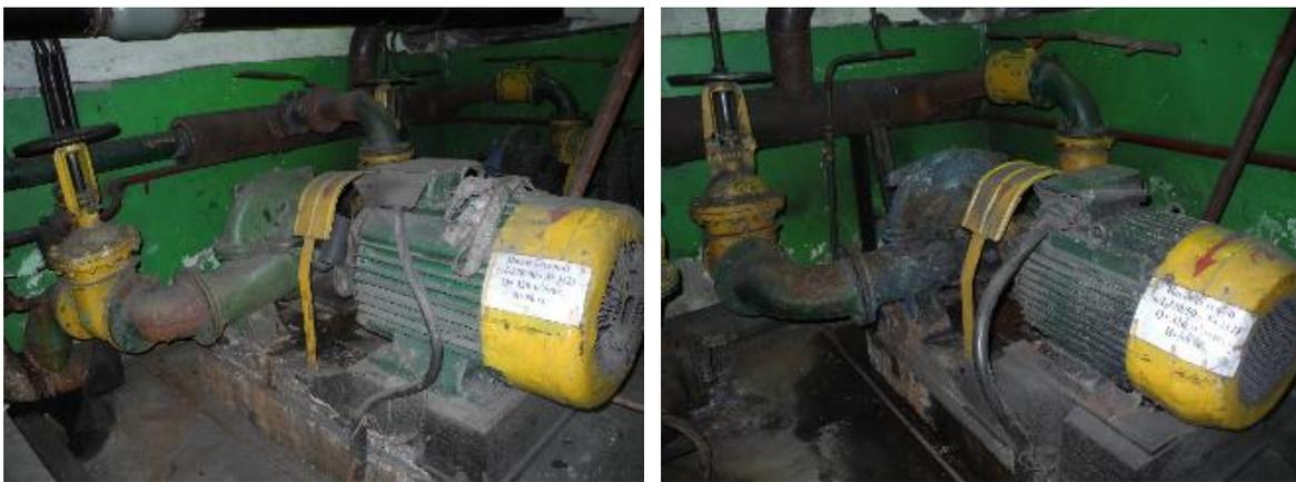
**Рисунок 3.1.45 – Сетевые насосы Д320-50, 75 кВт**
