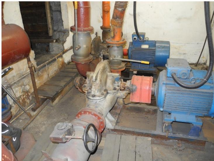
Рисунок 3.1.112 - Сетевые насосы Д320-50, 72 кВт
