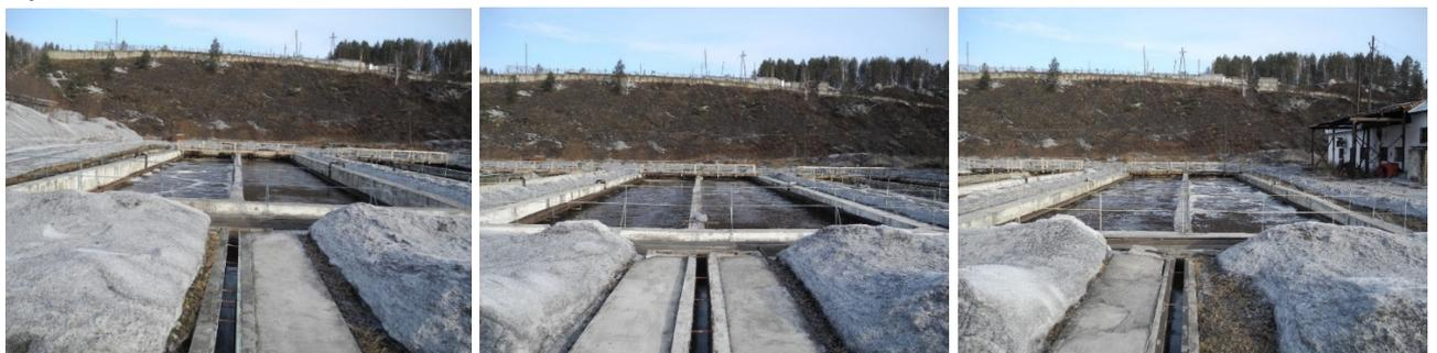
Рисунок 3.3.2 – Аэротенки очистных сооружений
