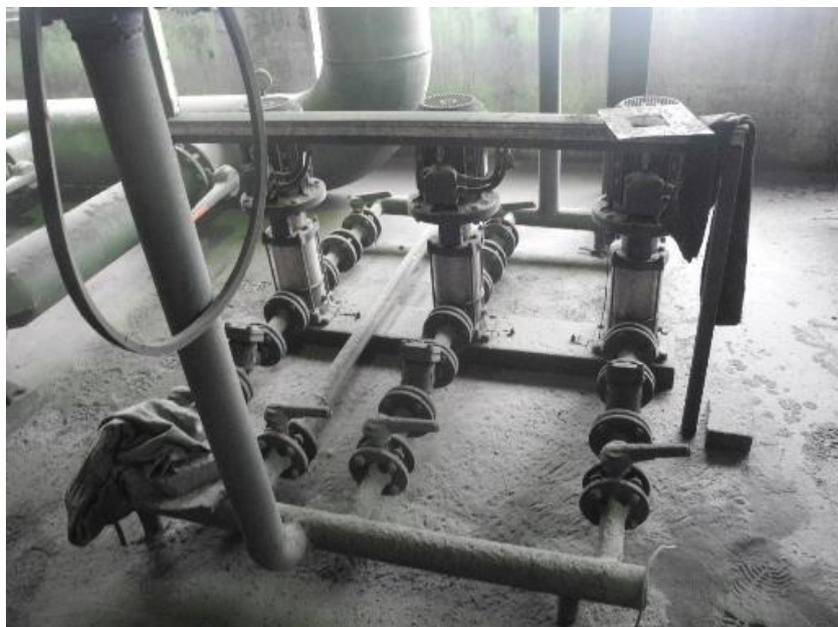
**Рисунок 3.1.11 - Подпиточные насосы KSB Movitec VSF 15/06 14, 5,5 кВт**
