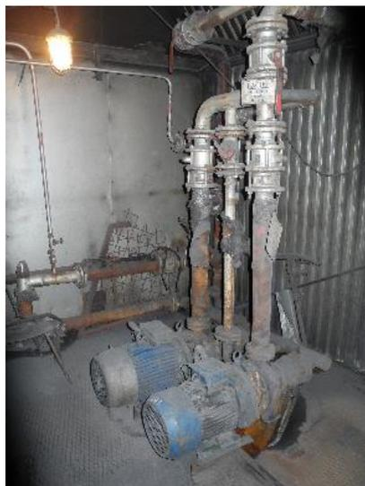
**Рисунок 3.1.94 - Циркуляционные насосы типа КМ-80-50-200**
