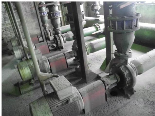
**Рисунок 3.1.12 - Рециркуляционные насосы KSB Etanorm 125-315, 30 кВт**
