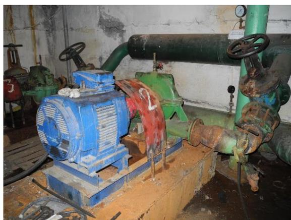
**Рисунок 3.1.24 – Сетевые насосы 1Д630-90**
