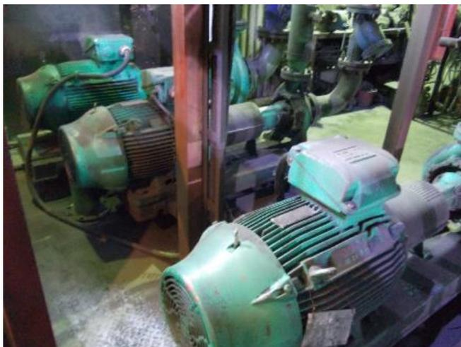
**Рисунок 3.1.59 – Сетевые насосы Wilo NL 100/250-55-2-12, 55 кВт и Wilo NL 150/400-55-4-12, 55 кВт**
