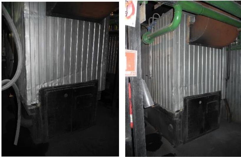
**Рисунок 3.1.80 – Общий вид котла КВм-1,25-95ШП**
