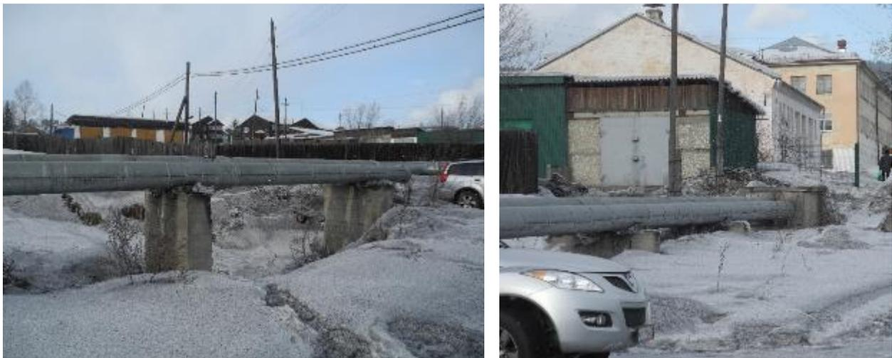
**Рисунок 3.1.67 – Тепловые сети, проложенные надземным способом от котельной БМК**
