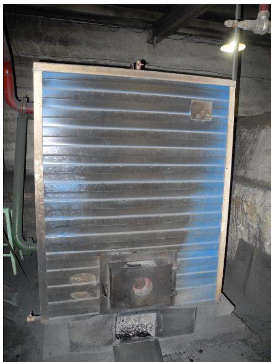
Рисунок 3.1.104 - Общий вид котла КВр-0.6
