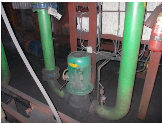
**Рисунок 3.1.60 – Циркуляционные насосы типа Wilo IL 80/160-11/2, 11 кВт**
