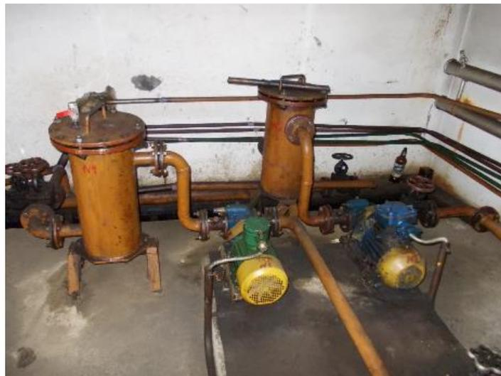
**Рисунок 3.1.46 – Топливные насосы типа НМШ 8-25-6,3/10**
