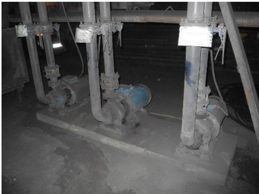
**Рисунок 3.1.10 - Подпиточные насосы KM100-65-200, 30 кВт**
