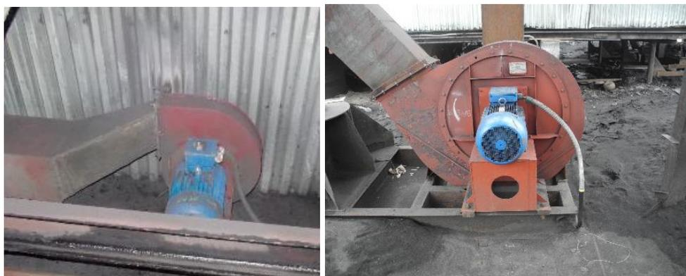
Рисунок 3.1.48 – Дутьевой вентилятор и дымосос
