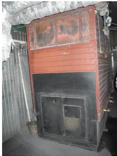
**Рисунок 3.1.81 – Общий вид котла КВм-1,25-95ШП**
