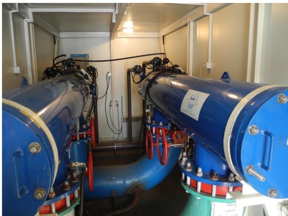
Рисунок 3.2.6 - Автоматические самоочищающиеся сетчатые фильтры «Yamit AF 814 PR»
