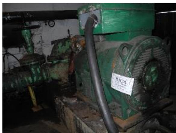
**Рисунок 3.1.23 – Сетевые насосы 1Д630-90**
