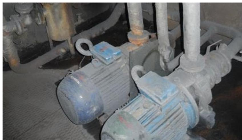
**Рисунок 3.1.95 - Циркуляционные насосы типа КМ-80-50-200**
