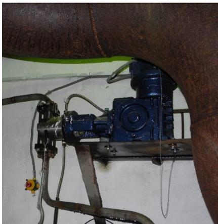
Рисунок 3.2.10 – Насос-дозатор
