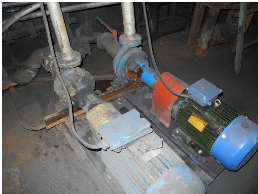
**Рисунок 3.1.109 - Сетевые насосы КМ100-65-200, 30 кВт**
