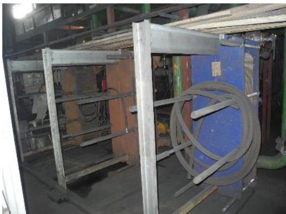
**Рисунок 3.1.58 - Пластинчатые теплообменники Ридан тип НН№62**
