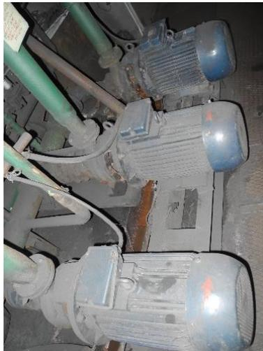
**Рисунок 3.1.72 – Сетевые насосы КМ100-65-200, 30 кВт**
