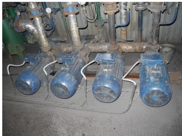
**Рисунок 3.1.82 – Сетевые насосы КМ100-65-200, 30 кВт**
