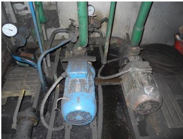
**Рисунок 3.1.37 – Сетевые насосы К 80-50-200, 15кВт**
