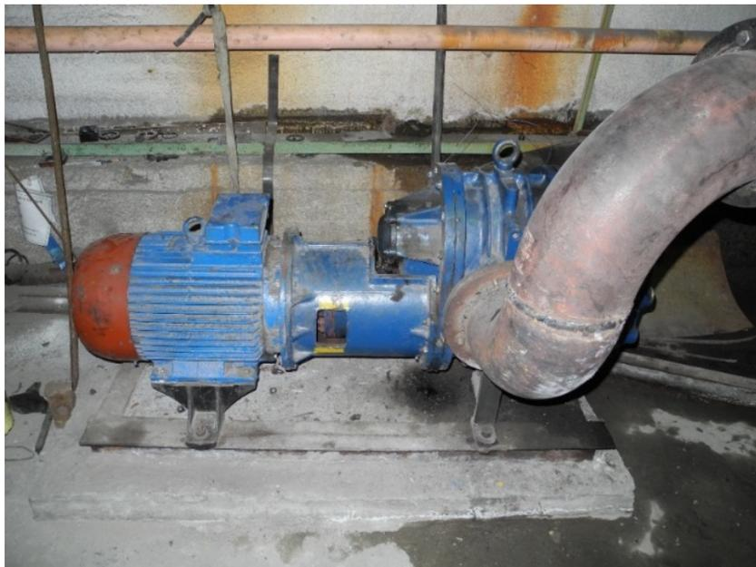
Рисунок 3.3.3 – Воздуходувки 32ВМФ-50-22,8-1,5-30
