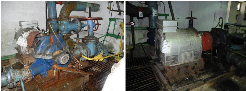
Рисунок 3.2.8 – Насосы 1Д630-90, установленные на НС №2
