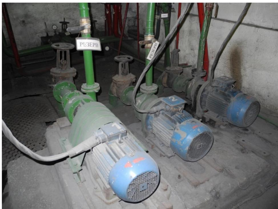
**Рисунок 3.1.106 - Сетевые насосы КМ100-65-200, 30 кВт**
