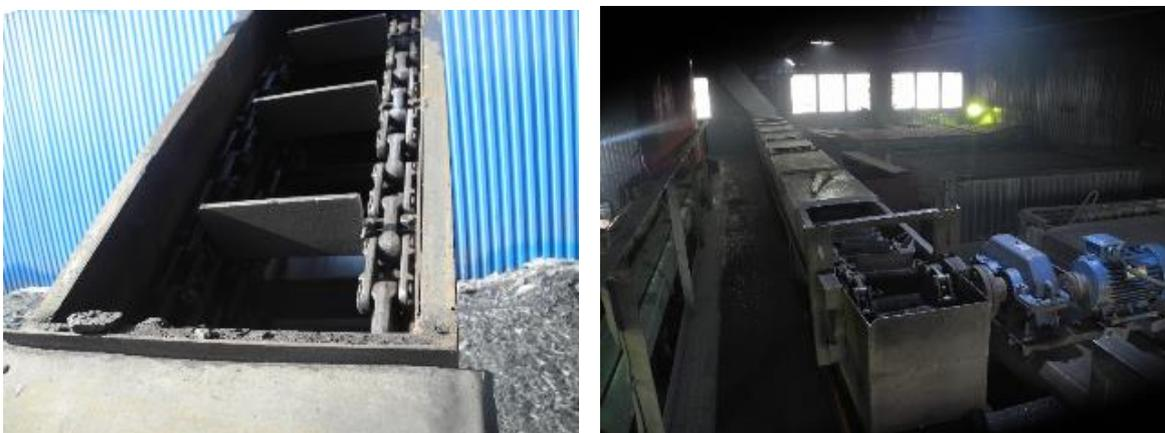
**Рисунок 3.1.61 – Транспортер топливоподачи**
