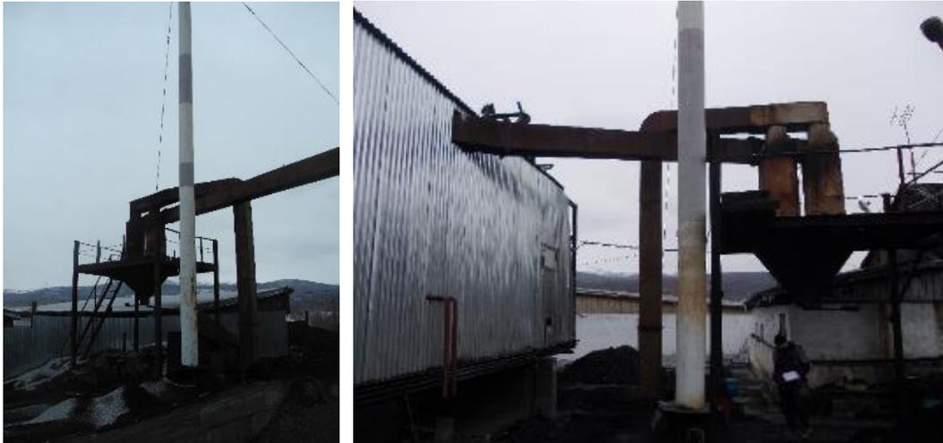
Рисунок 3.1.47 – Дымовые трубы котлов КВм – 2,5
