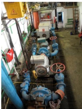
Рисунок 3.2.9 – Насосы типа 1Д630-90, установленные на НС №2
