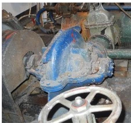
**Рисунок 3.1.93 – Сетевые насосы (слева - Grundfos NB 100-200/219, справа - Д320-50)**
