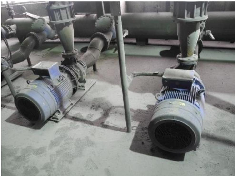
**Рисунок 3.1.8 – Сетевые насосы KSB ETABLOC 100-200/4502 GN6, 45 кВт.**
