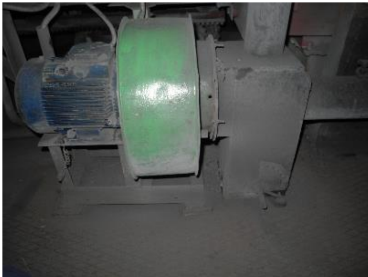
Рисунок 1.2.94 – Дутьевой вентилятор
