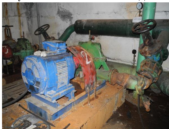
Рисунок 1.2.24 – Сетевые насосы 1Д630-90
