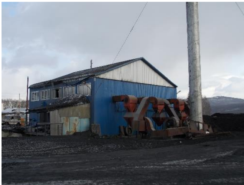
Рисунок 1.2.63 – Общий вид котельной БМК
