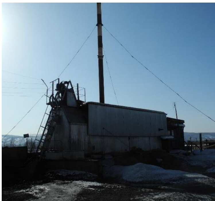
Рисунок 1.2.34 – Общий вид котельной №3
