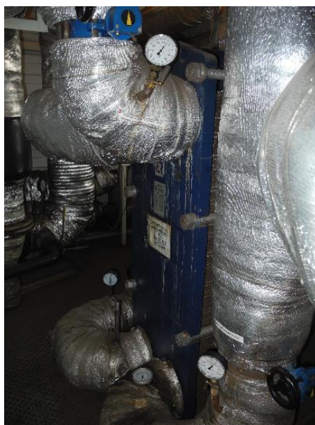
Рисунок 1.3.22 - Пластинчатые теплообменники Ридан тип HH№41 ЦТП №4
