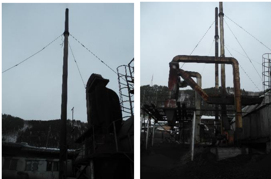
Рисунок 1.2.105 – Дымовые трубы котельной СМП
