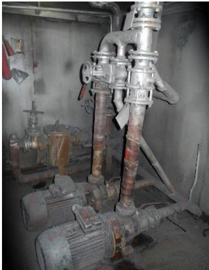
Рисунок 1.2.102 - Циркуляционные насосы типа КМ-80-50-200
