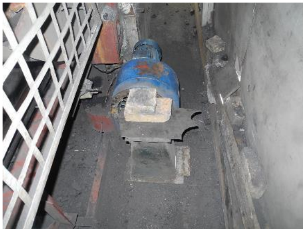
Рисунок 1.2.83 – Дутьевой вентилятор
