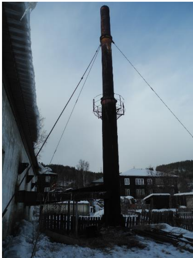
Рисунок 1.2.61 – Дымовая труба котельной «Металлист»
