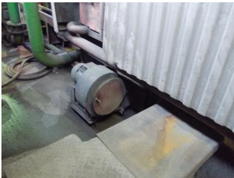
Рисунок 1.2.72 – Дутьевой вентилятор
