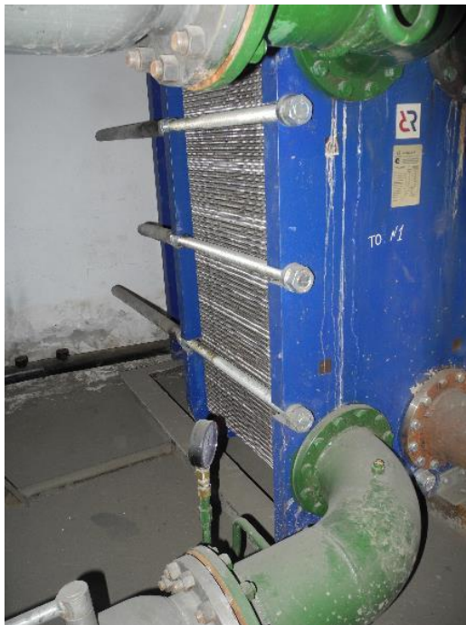
Рисунок 1.3.23 - Пластина́тые теплообменники Ридан тип НН№65 ЦТП №4А
