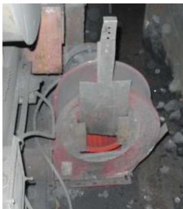
Рисунок 1.2.106 – Дутьевой вентилятор
