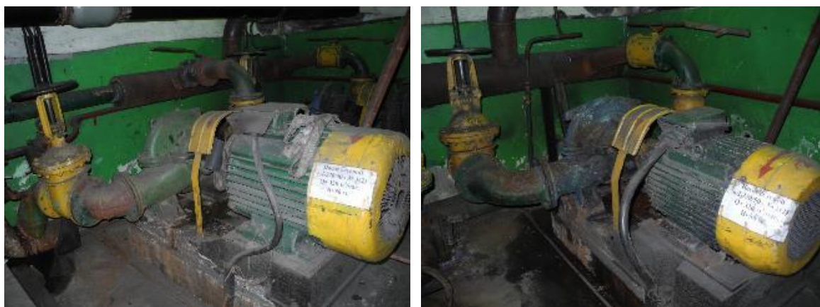
Рисунок 1.2.47 – Сетевые насосы Д320-50, 75 кВт
