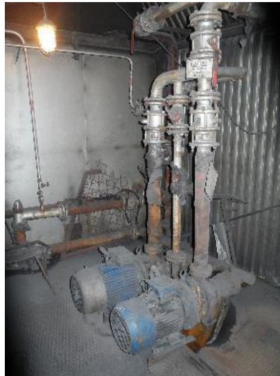
Рисунок 1.2.102 - Циркуляционные насосы типа КМ-80-50-200
