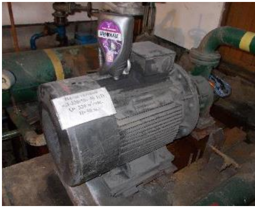
Рисунок 1.2.101 – Сетевые насосы (слева - Grundfos NB 100-200/219, справа - Д320-50)
