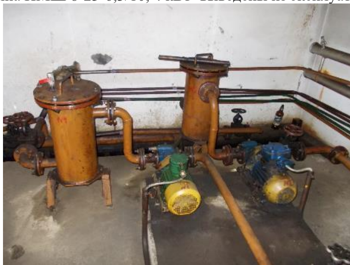
Рисунок 1.2.48 – Топливные насосы типа НМШ 8-25-6,3/10
