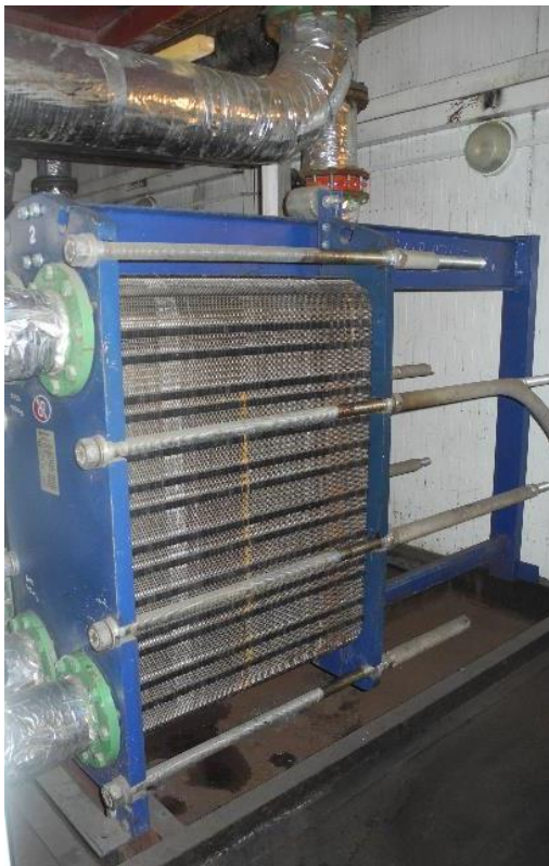
Рисунок 1.3.21 - Пластинчатые теплообменники Ридан тип HH№41 ЦТП №1
