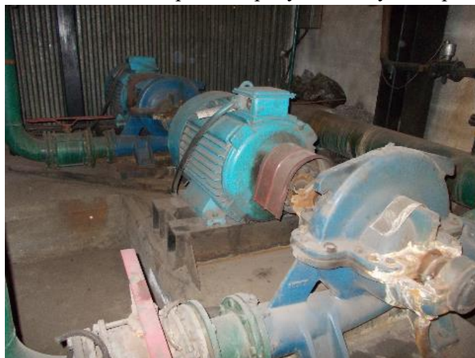
Рисунок 1.2.60 – Сетевые насосы Д320-50, 75 кВт
