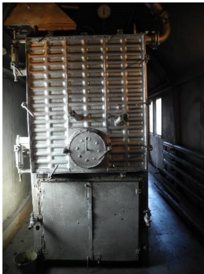
Рисунок 1.2.79 – Общий вид котла КСВм- 1,25К
