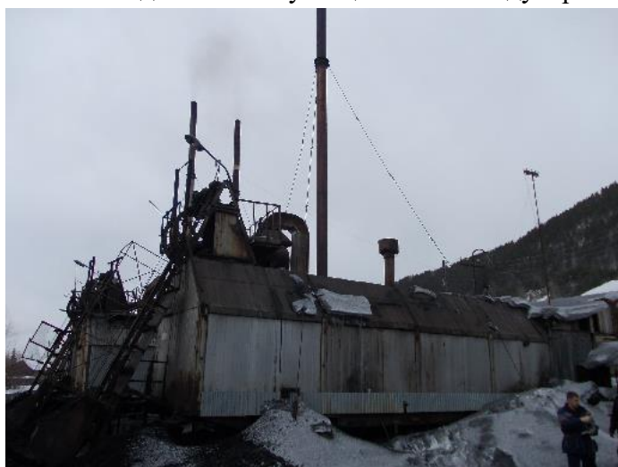
Рисунок 1.2.97 – Общий вид котельной СМП
