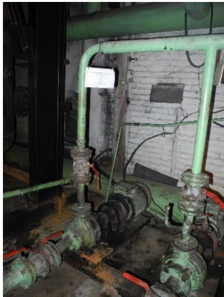
Рисунок 1.2.25 – Конденсатные насосы КМ-80-50-200
