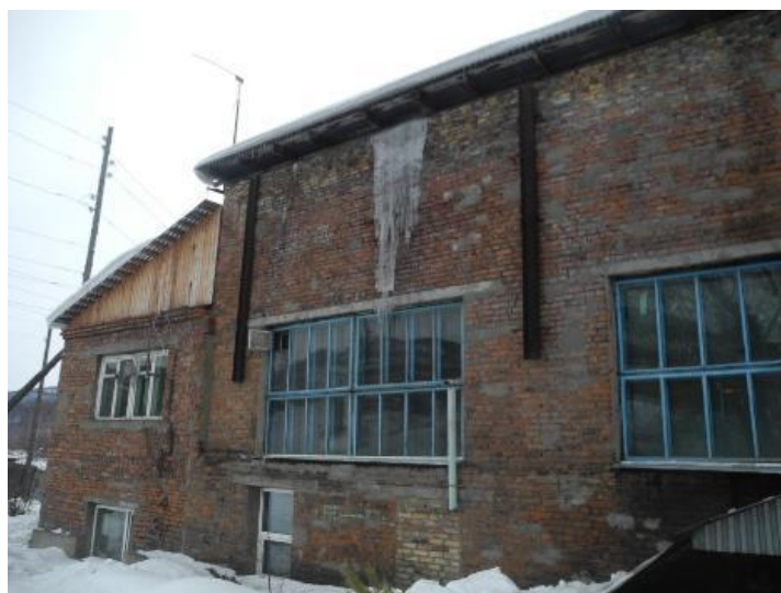
Рисунок 1.2.33 – Здание котельной ЦОК №2
