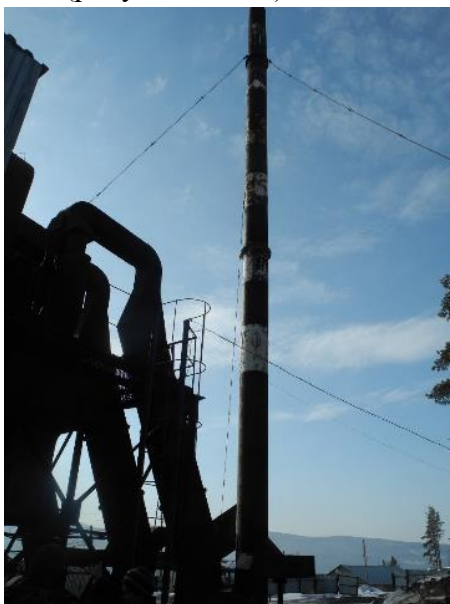
Рисунок 1.2.92 – Дымовая труба котельной МО-44
