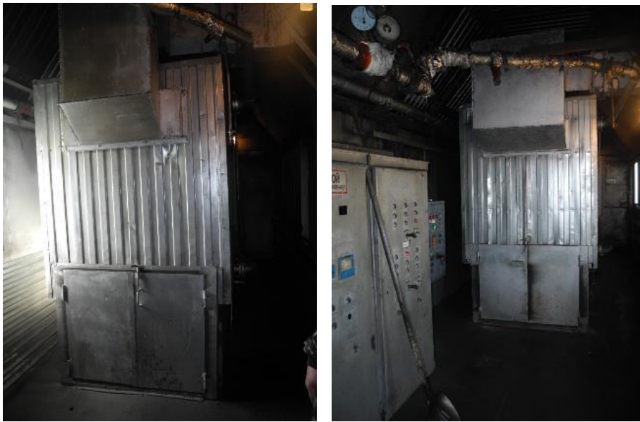
Рисунок 1.2.78 – Общий вид котла КВм-1,25-95ШП
