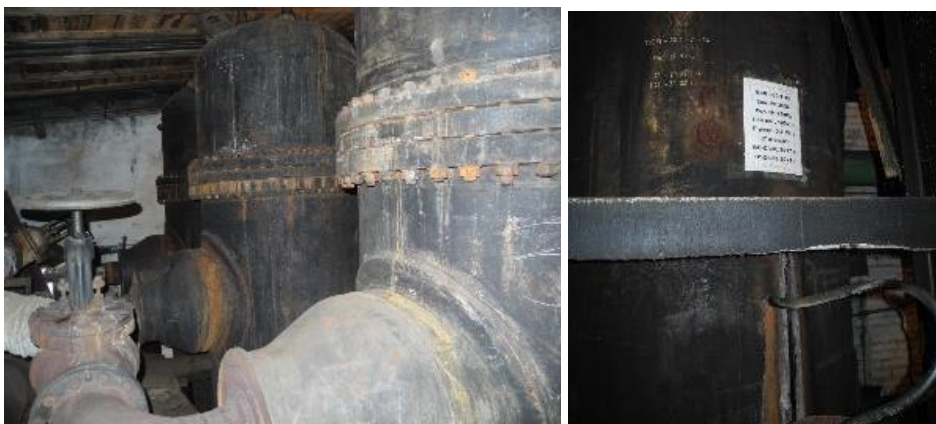
Рисунок 1.2.31 – Подогреватели сетевой воды
