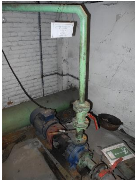
Рисунок 1.2.25 – Конденсатные насосы КМ-80-50-200
