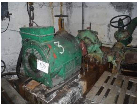
Рисунок 1.2.23 – Сетевые насосы 1Д630-90
