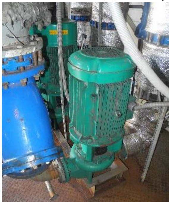
Рисунок 1.3.27 – Циркуляционные насосы Wilo IL 100/190-30/2, 30 кВт
