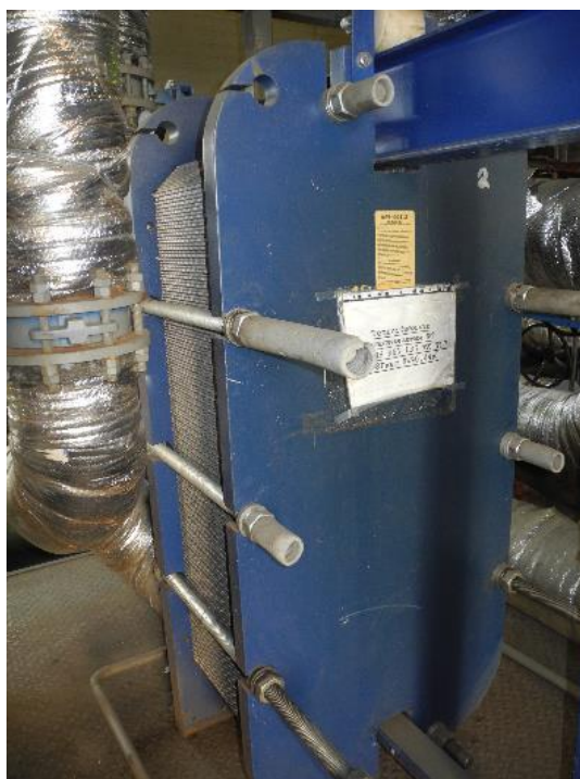
Рисунок 1.3.24 - Пластина́тые теплообменники Ридан тип НН№65 ЦТП №6
