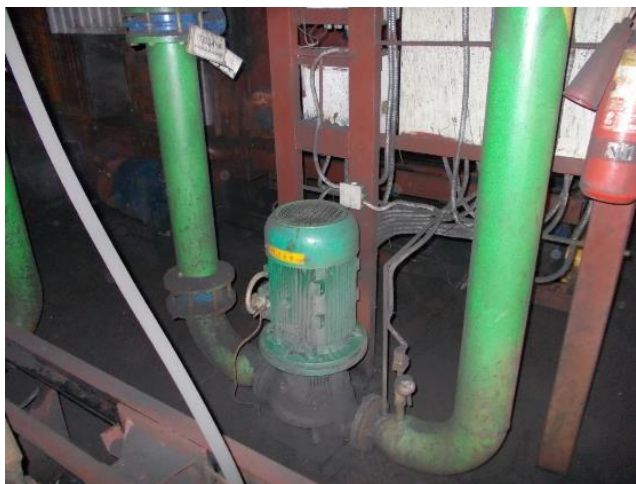
Рисунок 1.2.68 – Циркуляционные насосы типа Wilo IL 80/160-11/2, 11 кВт
