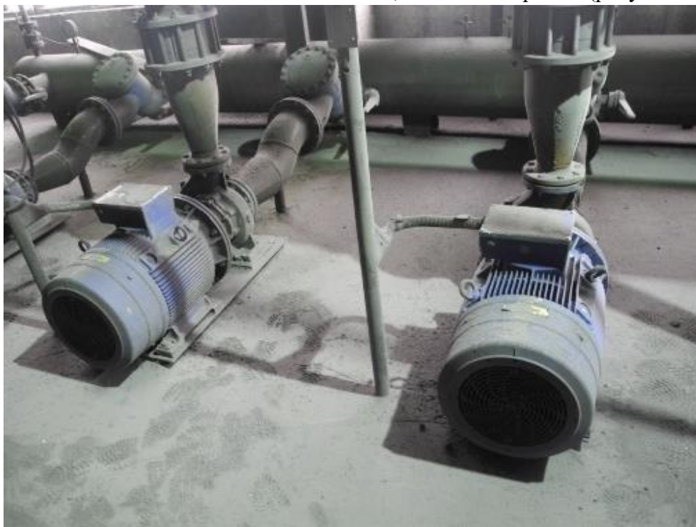
Рисунок 1.2.8 – Сетевые насосы KSB ETABLOC 100-200/4502 GN6, 45 кВт.
