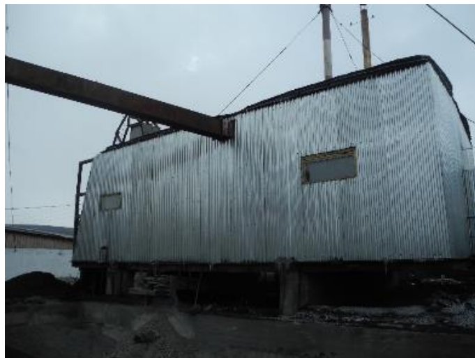
Рисунок 1.2.42 – Общий вид котельной №7
