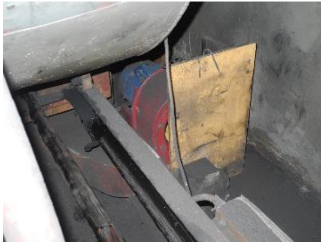
Рисунок 1.2.39 – Дутьевой вентилятор
