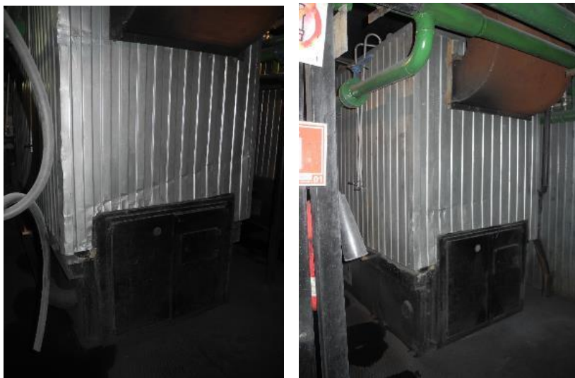
Рисунок 1.2.88 – Общий вид котла КВм-1,25-95ШП
