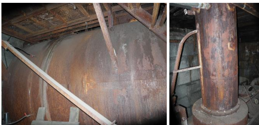
Рисунок 1.2.32 – Деаэратор
