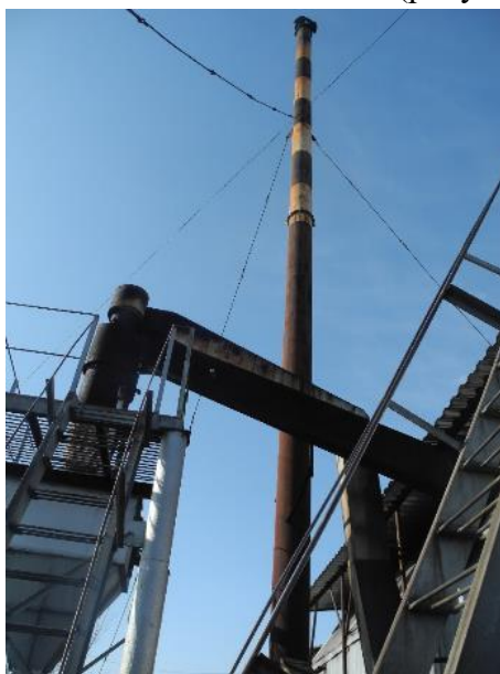
Рисунок 1.2.38 – Дымовая труба котельной №3
