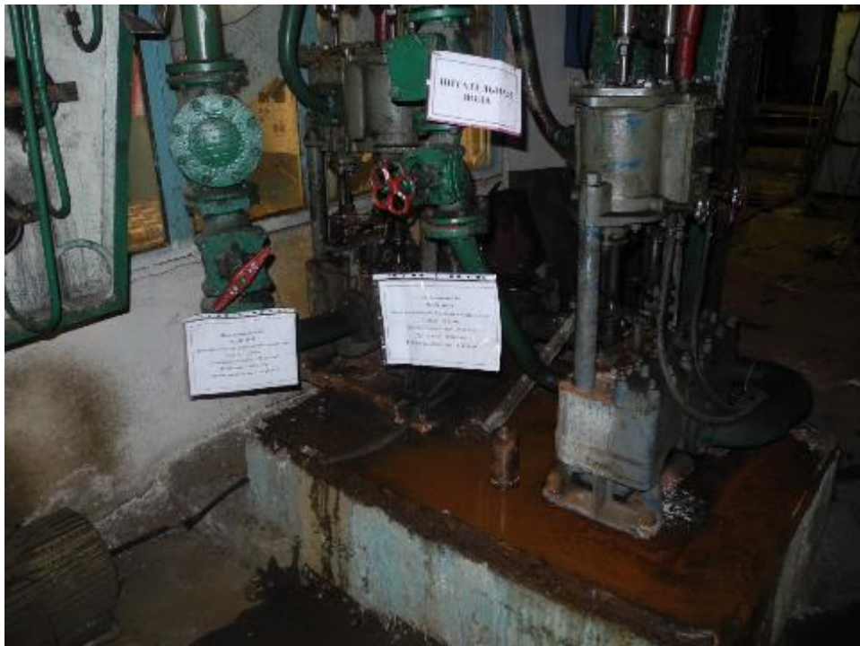
Рисунок 1.2.27 - Питательный насосы типа ПДВ-16/20
