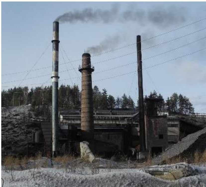
Рисунок 1.2.13 – Дымовые трубы: котлов №№ 2,3 и 4 – слева; котла № 1– справа
