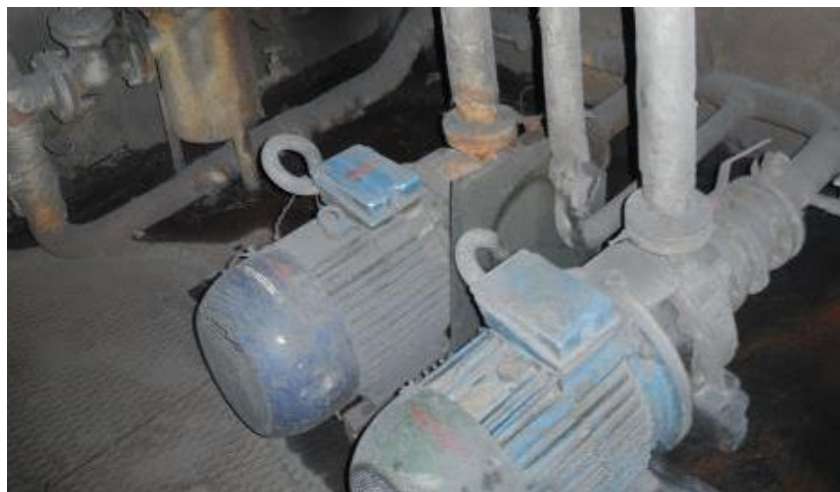
Рисунок 1.2.103 - Циркуляционные насосы типа КМ-80-50-200
