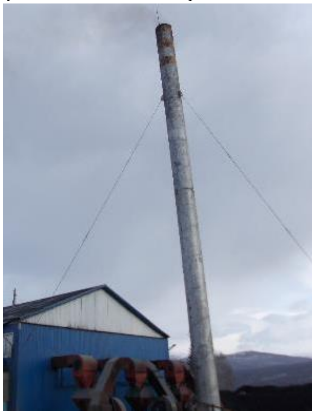
Рисунок 1.2.71 – Дымовая труба котельной БМК
