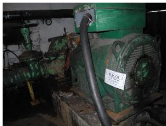
Рисунок 1.2.23 – Сетевые насосы 1Д630-90
