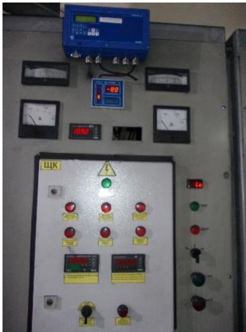
Рисунок 1.2.16 – Щит управления котлами
