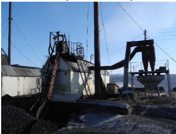
Рисунок 1.2.82 – Дымовые трубы котельной МК-135
