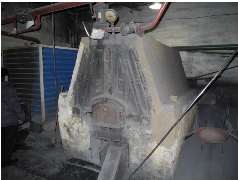
Рисунок 1.2.112 - Общий вид котла Универсал-6
