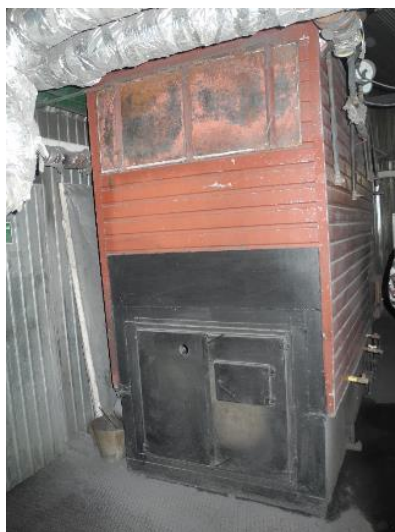
Рисунок 1.2.89 – Общий вид котла КВм-1,25-95ШП
