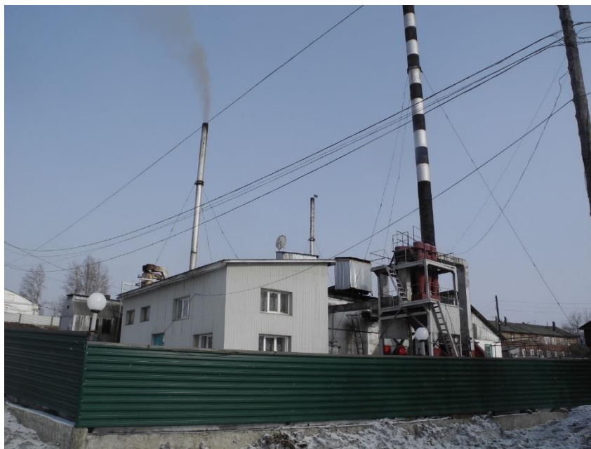
Рисунок 1.2.117 - Общий вид котельной УКМТ-1
