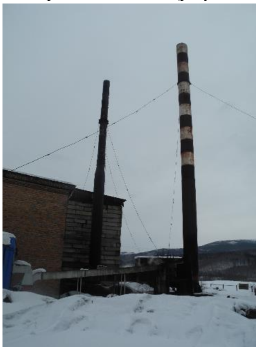
Рисунок 1.2.29 – Дымовые трубы ЦОК №2
