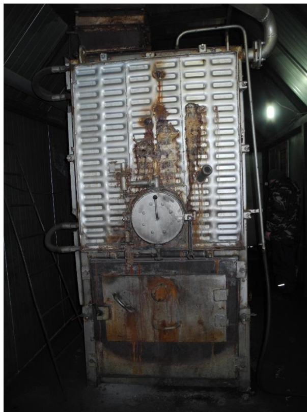
Рисунок 1.2.115 - Общий вид котла КСВ-1,25
