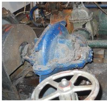
Рисунок 1.2.101 – Сетевые насосы (слева - Grundfos NB 100-200/219, справа - Д320-50)
