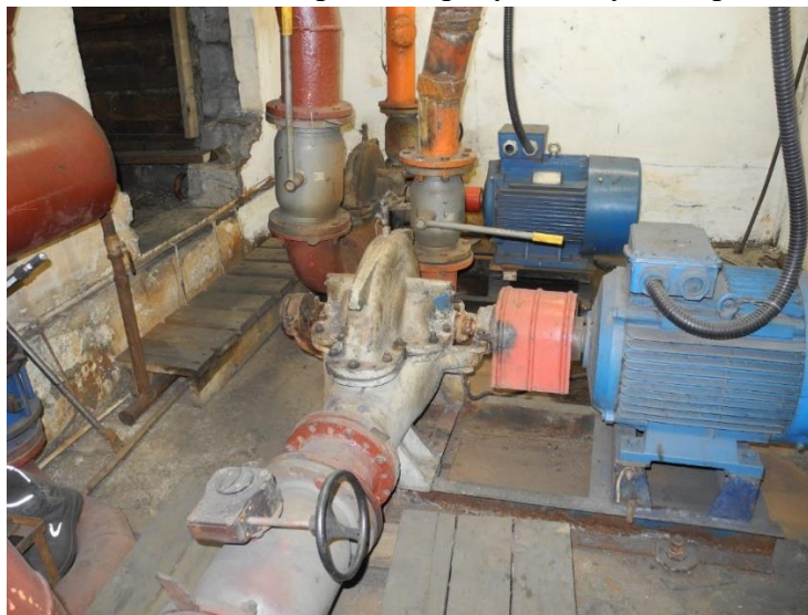
Рисунок 1.2.119 - Сетевые насосы Д320-50, 72 кВт
