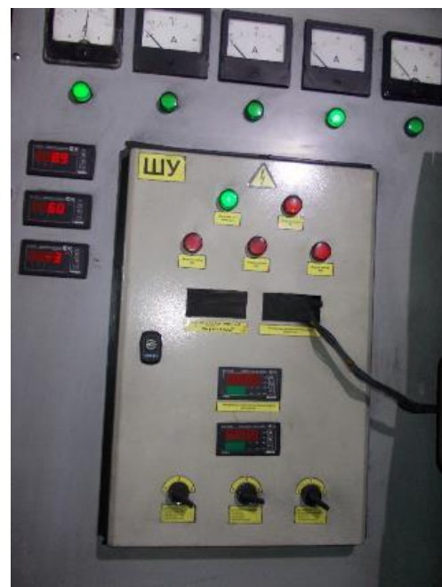
Рисунок 1.2.16 – Щит управления котлами
