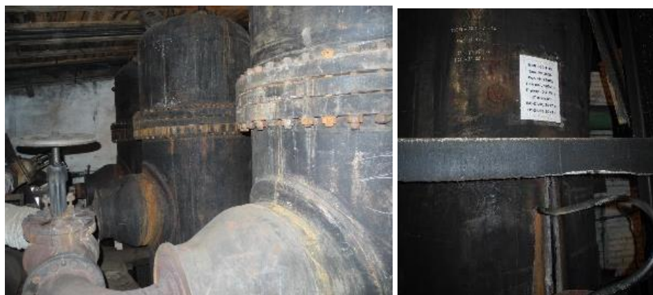
Рисунок 3.1.31 – Подогреватели сетевой воды
