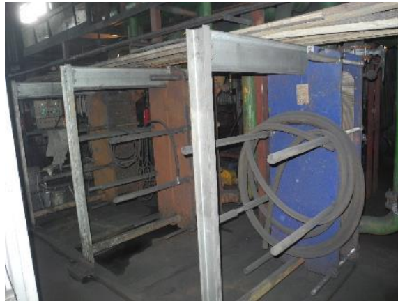
Рисунок 3.1.58 - Пластинчатые теплообменники Ридан тип НН№62
