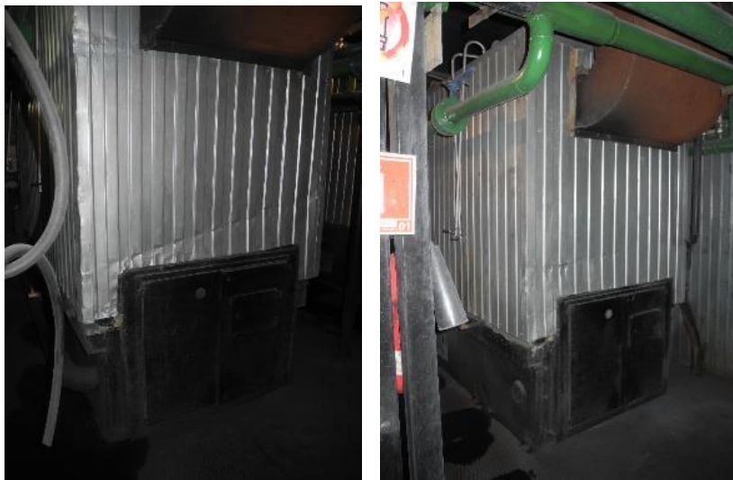
Рисунок 3.1.80 – Общий вид котла КВм-1,25-95ШП
