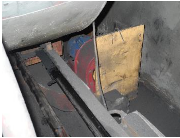
Рисунок 3.1.39 – Дутьевой вентилятор
