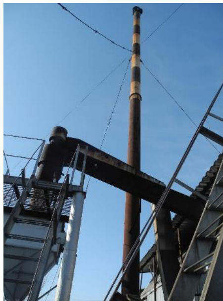
Рисунок 3.1.38 – Дымовая труба котельной №3
