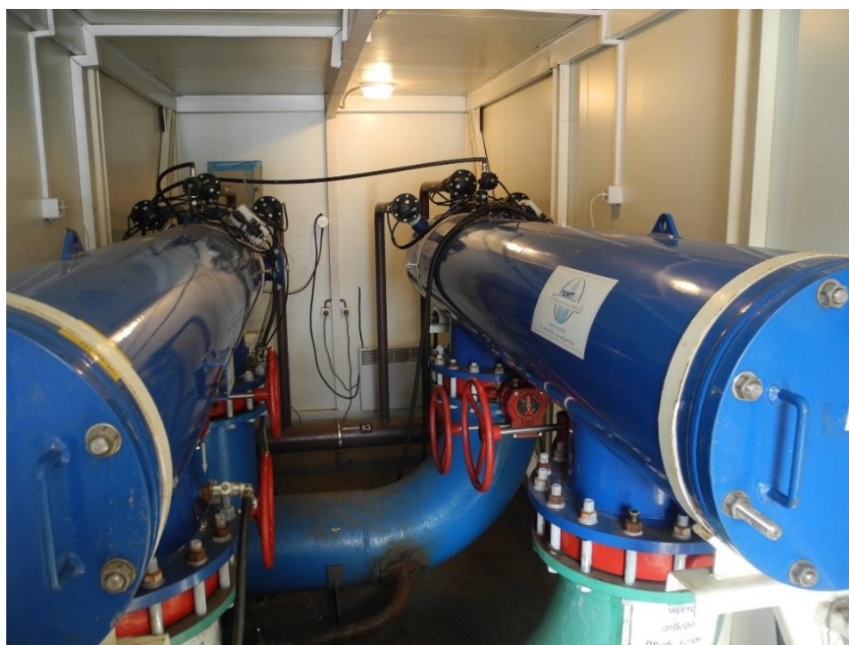
Рисунок 3.2.6 - Автоматические самоочищающиеся сетчатые фильтры «Yamit AF 814 PR»
