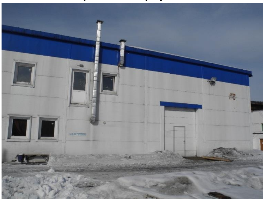
Рисунок 3.2.4 – Общий вид станции водоочистки
