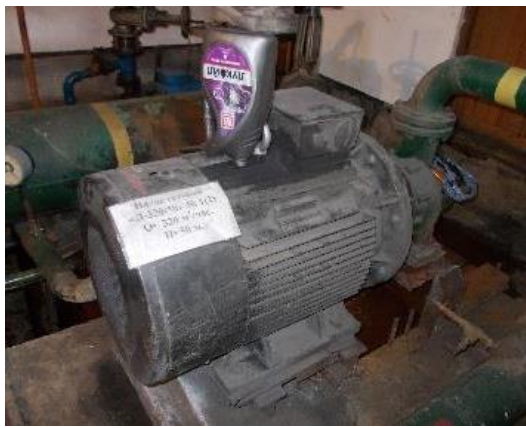
Рисунок 3.1.93 – Сетевые насосы (слева - Grundfos NB 100-200/219, справа - Д320-50)
