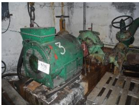
Рисунок 3.1.23 – Сетевые насосы 1Д630-90
