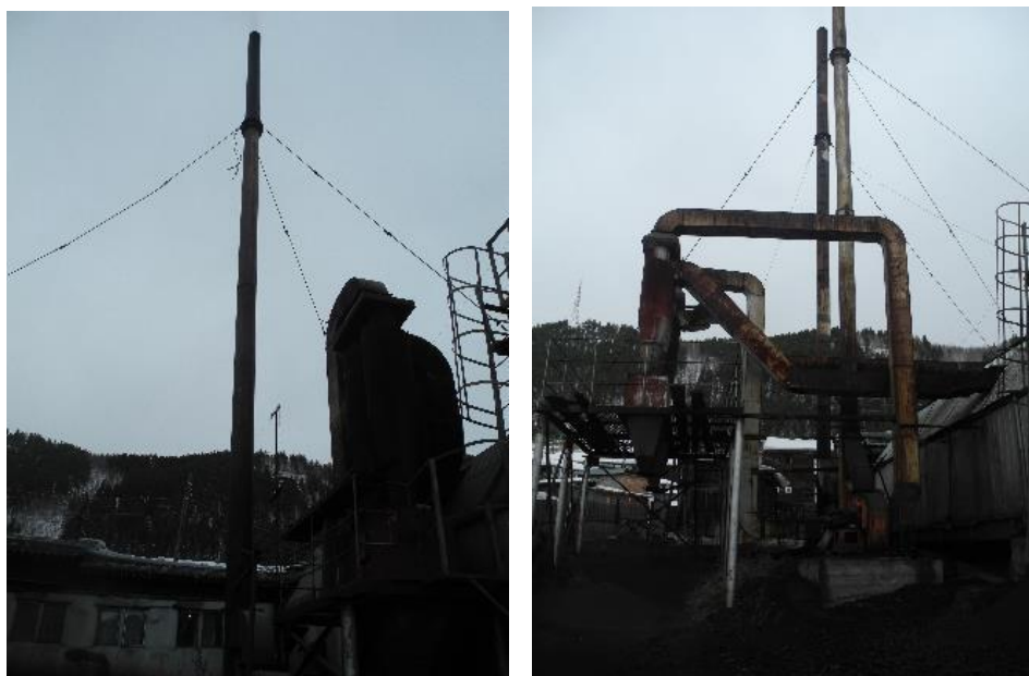
Рисунок 3.1.98 – Дымовые трубы котельной СМП
