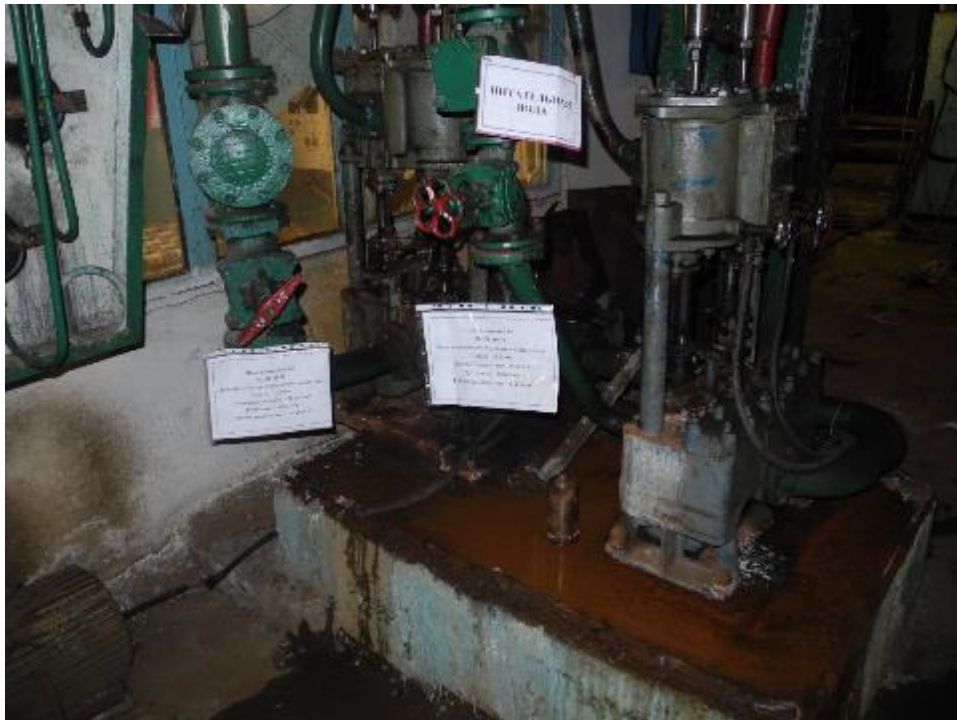
Рисунок 3.1.27 - Питательный насосы типа ПДВ-16/20
