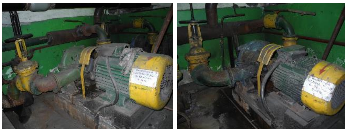
Рисунок 3.1.45 – Сетевые насосы Д320-50, 75 кВт
