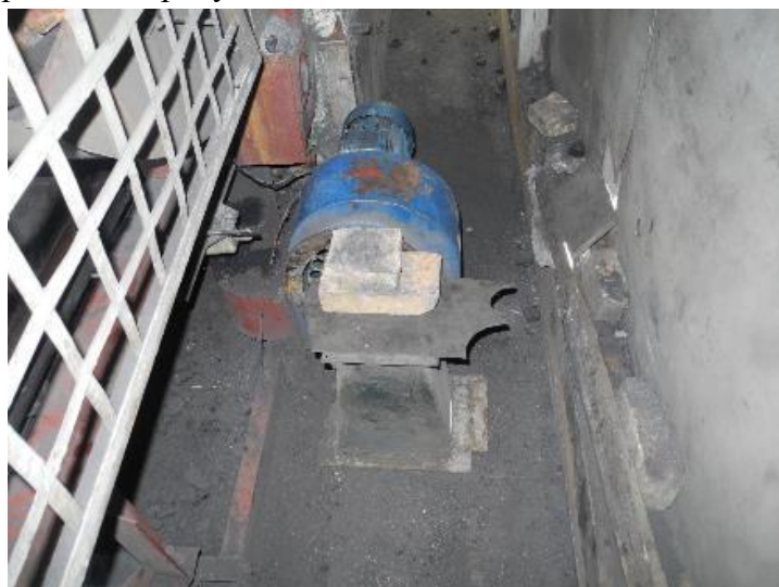
Рисунок 3.1.75 – Дутьевой вентилятор
