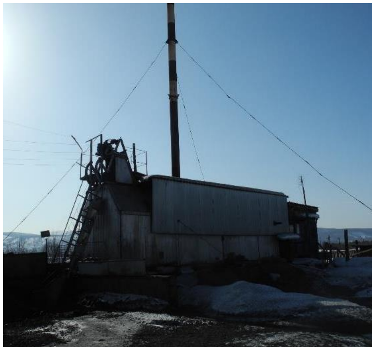
Рисунок 3.1.34 – Общий вид котельной №3
