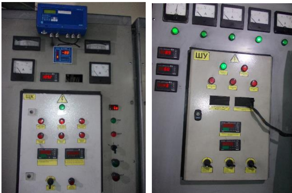
Рисунок 3.1.16 – Щит управления котлами
