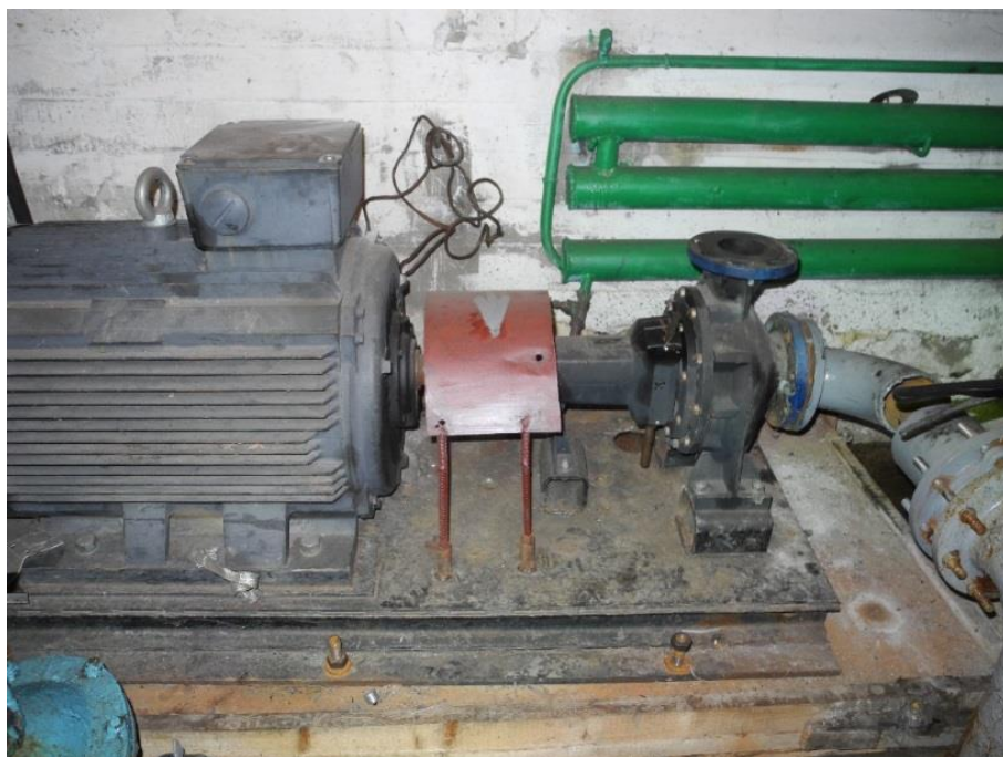
Рисунок 3.2.15 – Насос Grundfos NK 100-250/270
