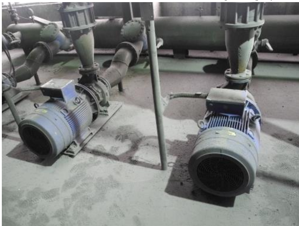
Рисунок 3.1.8 – Сетевые насосы KSB ETABLOC 100-200/4502 GN6, 45 кВт.
