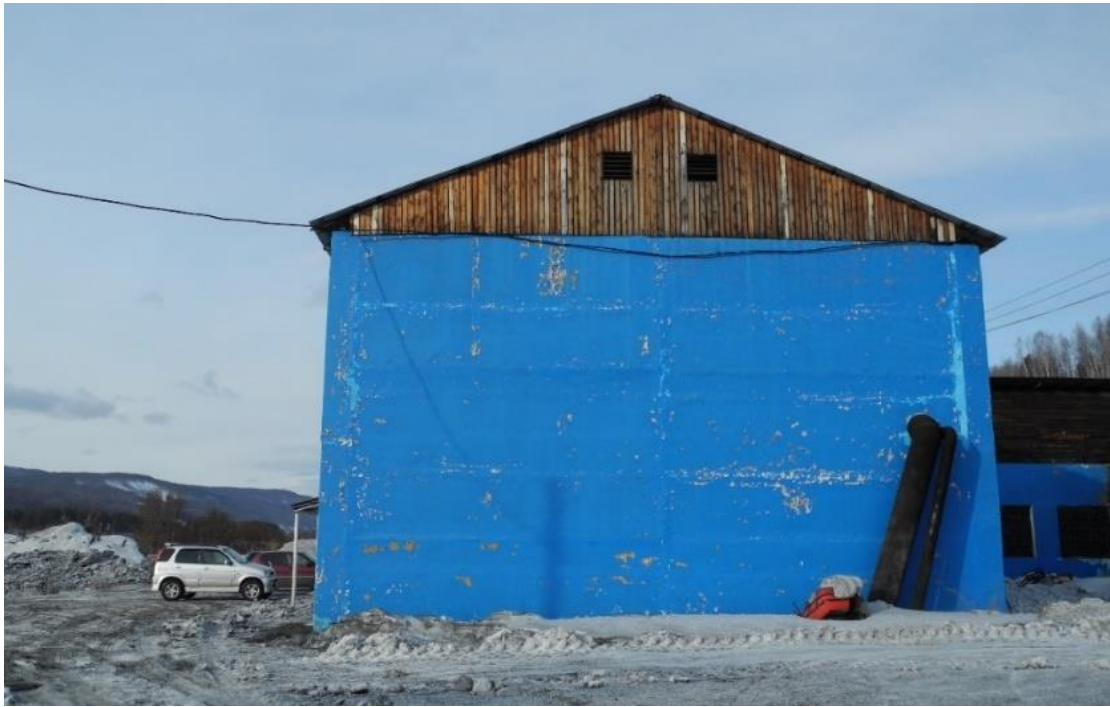
Рисунок 3.3.1 – Общий вид здания КОС
