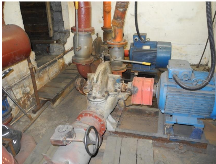
Рисунок 3.1.112 - Сетевые насосы Д320-50, 72 кВт
