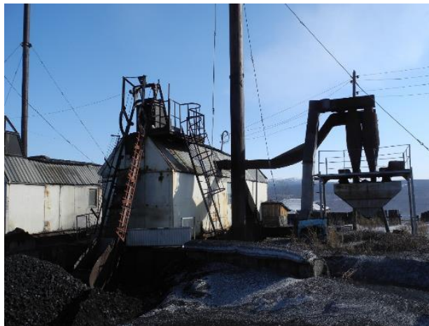
Рисунок 3.1.74 – Дымовые трубы котельной МК-135
