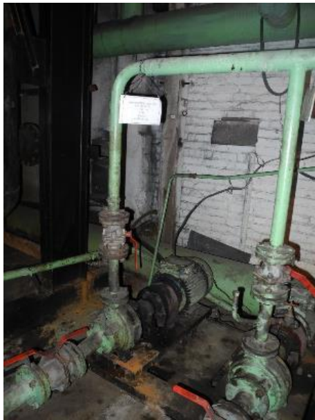
Рисунок 3.1.25 – Конденсатные насосы КМ-80-50-200
