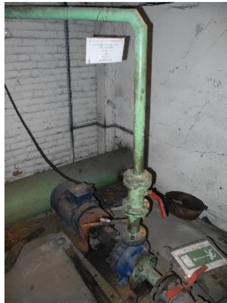
Рисунок 3.1.25 – Конденсатные насосы КМ-80-50-200
