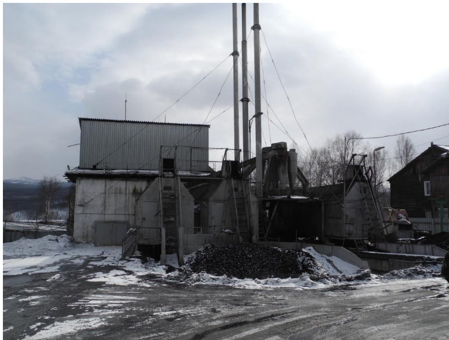
Рисунок 3.1.107 - Общий вид котельной «Витим»
