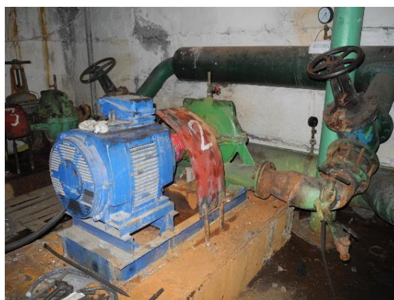
Рисунок 3.1.24 – Сетевые насосы 1Д630-90
