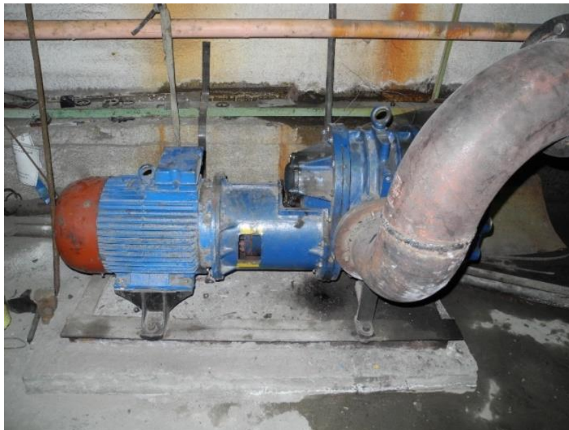
Рисунок 3.3.3 – Воздуходувки 32BMФ-50-22,8-1,5-30
