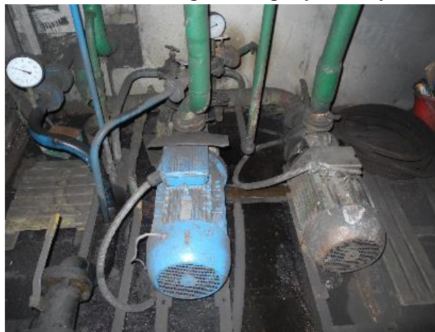
Рисунок 3.1.37 – Сетевые насосы К 80-50-200, 15кВт
