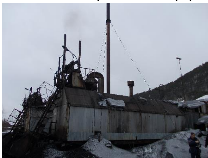
Рисунок 3.1.89 – Общий вид котельной СМП
