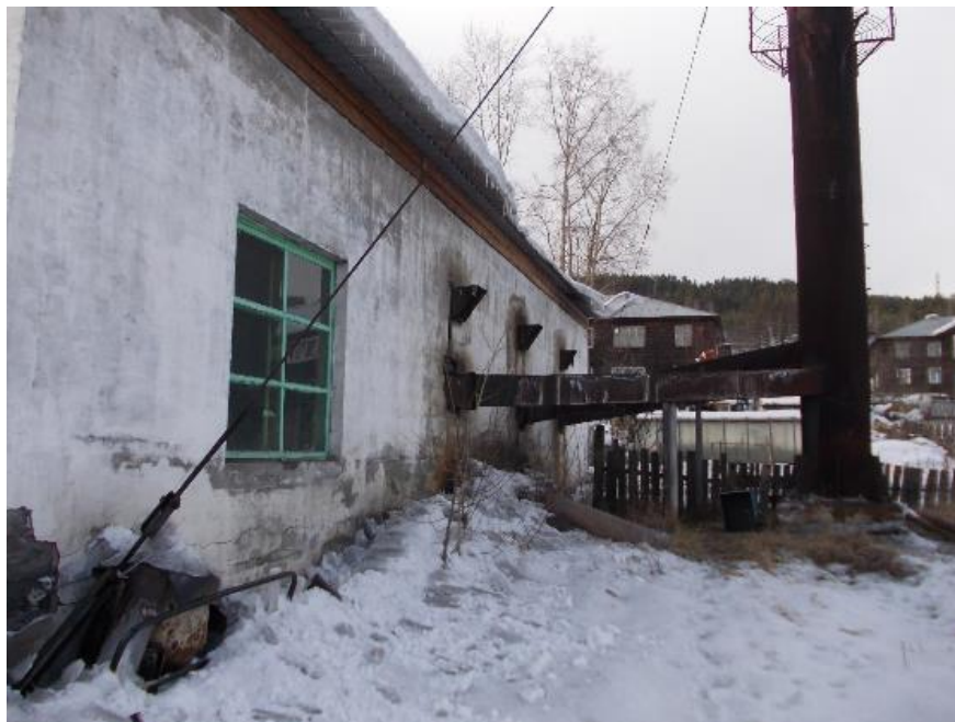
Рисунок 3.1.50 – Общий вид котельной «Металлист»
