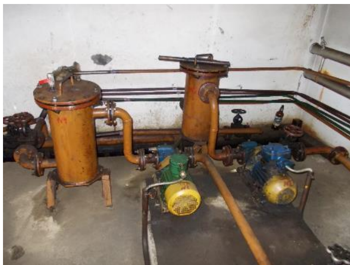
Рисунок 3.1.46 – Топливные насосы типа НМШ 8-25-6,3/10
