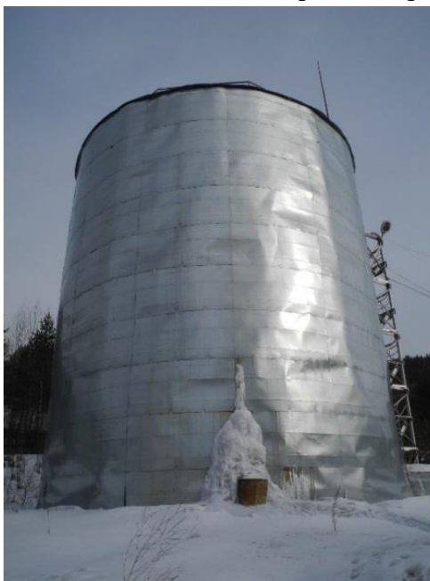
Рисунок 3.2.3 – Регулирующая ёмкость 1000 м 3
