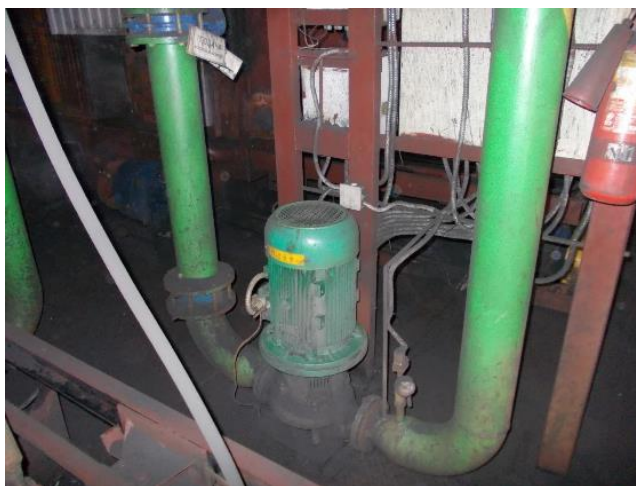
Рисунок 3.1.60 – Циркуляционные насосы типа Wilo IL 80/160-11/2, 11 кВт
