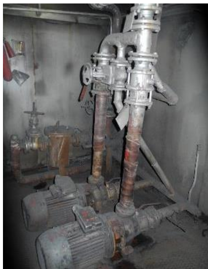
Рисунок 3.1.94 - Циркуляционные насосы типа КМ-80-50-200
