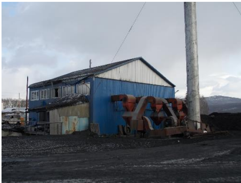
Рисунок 3.1.55 – Общий вид котельной БМК
