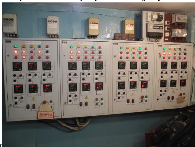
Рисунок 3.1.30 - Щит управления котлами
