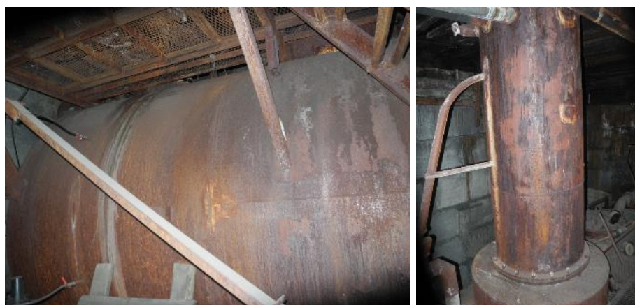
Рисунок 3.1.32 – Деаэратор
