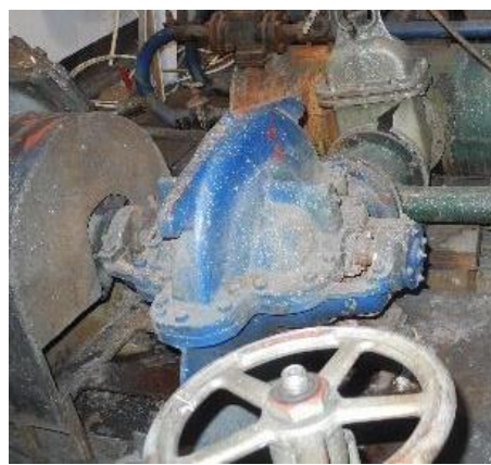
Рисунок 3.1.93 – Сетевые насосы (слева - Grundfos NB 100-200/219, справа - Д320-50)
