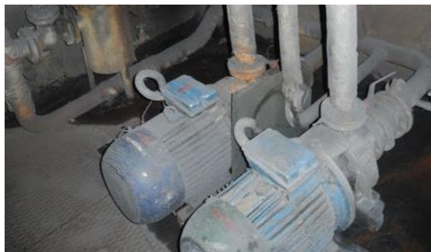
Рисунок 3.1.95 - Циркуляционные насосы типа КМ-80-50-200
