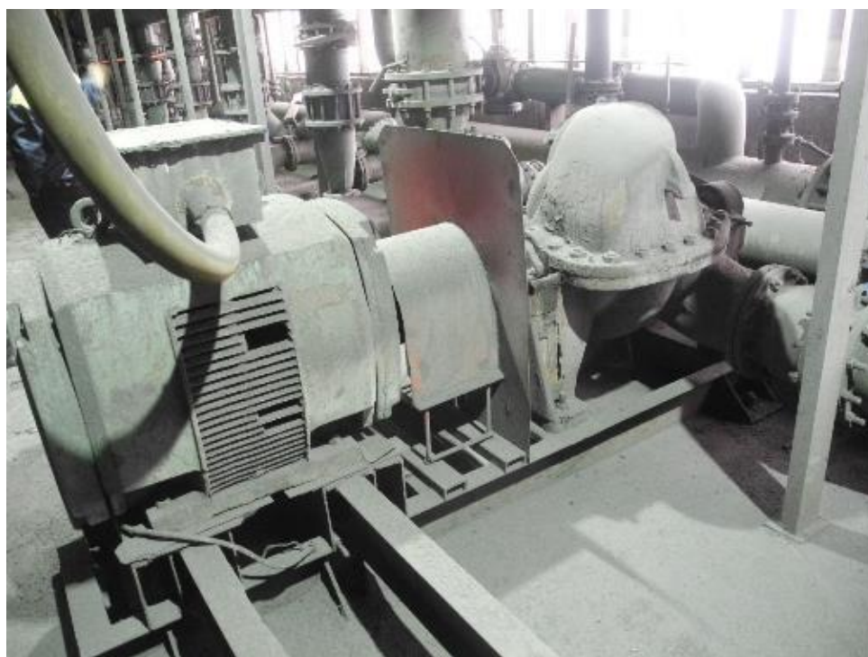
Рисунок 3.1.9 - Сетевые насосы ЦН-400-105, 200 кВт
