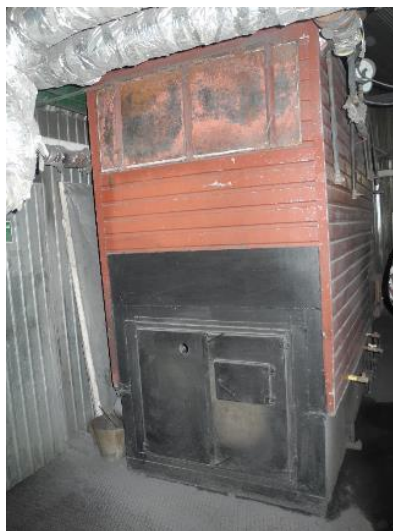
Рисунок 3.1.81 – Общий вид котла КВм-1,25-95ШП
