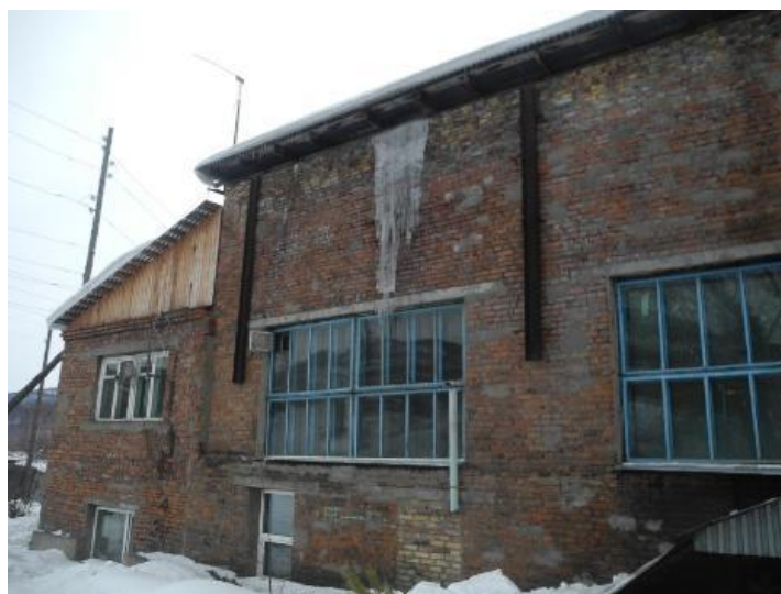
Рисунок 3.1.33 – Здание котельной ЦОК №2
