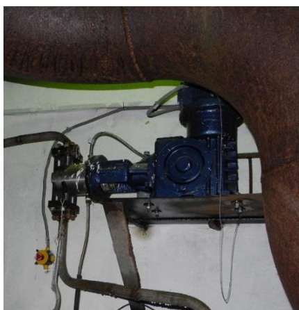
Рисунок 3.2.10 – Насос-дозатор
