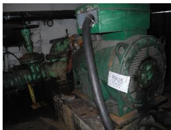
Рисунок 3.1.23 – Сетевые насосы 1Д630-90
