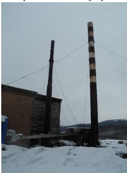
Рисунок 3.1.29 – Дымовые трубы ЦОК №2
