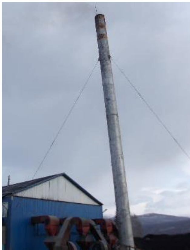
Рисунок 3.1.63 – Дымовая труба котельной БМК
