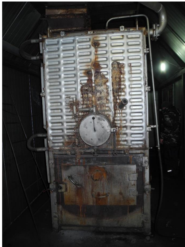
Рисунок 3.1.108 - Общий вид котла КСВ-1,25
