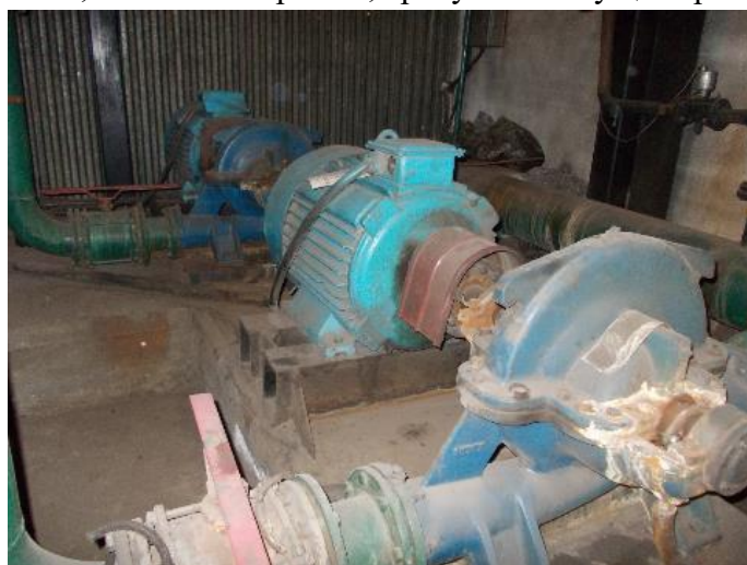
Рисунок 3.1.52 – Сетевые насосы ДЗ20-50, 75 кВт
