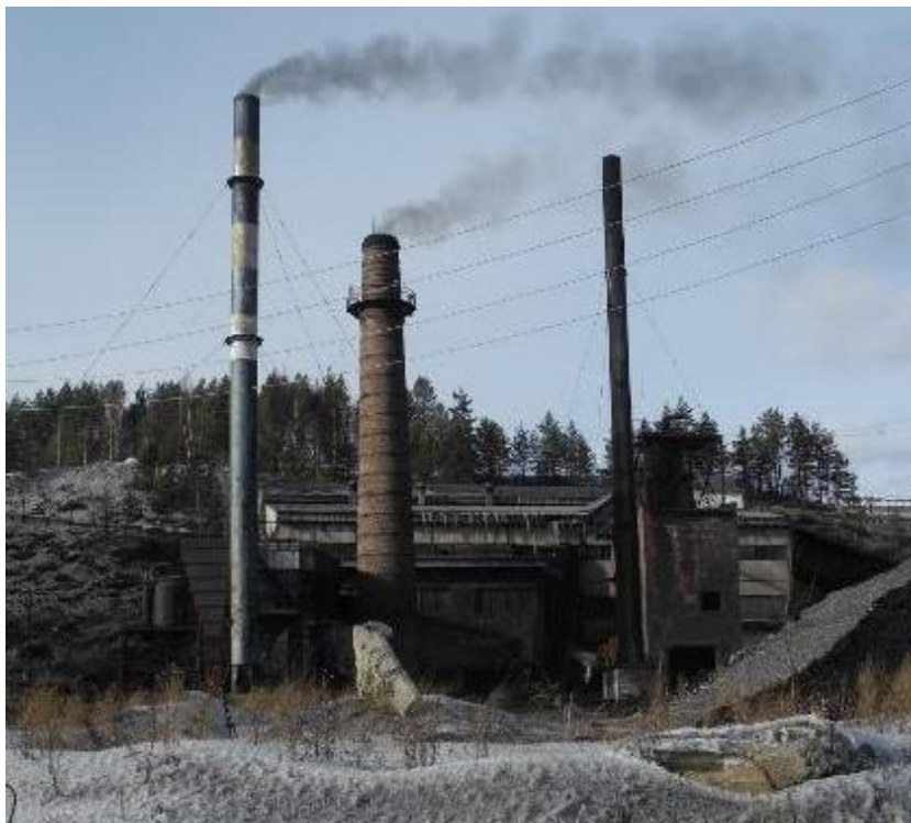
Рисунок 3.1.13 – Дымовые трубы: котлов №№ 2,3 и 4 – слева; котла № 1– справа
