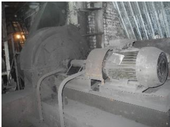
Рисунок 3.1.14 – Дутьевые вентиляторы
