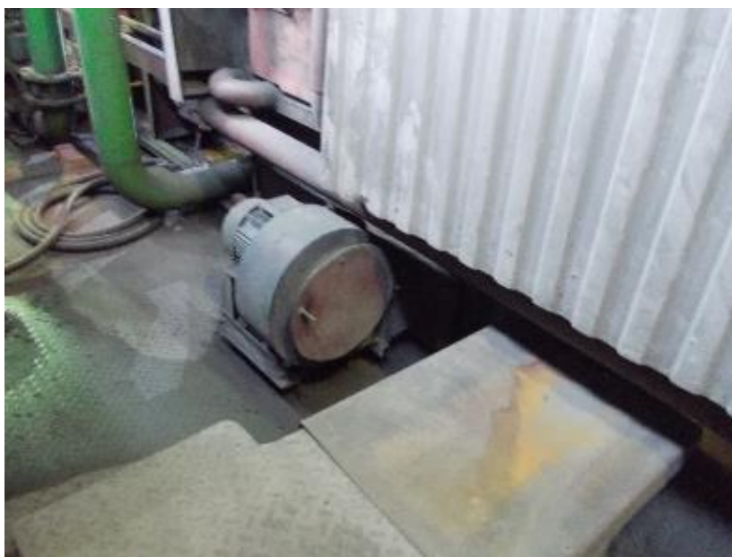
Рисунок 3.1.64 – Дутьевой вентилятор
