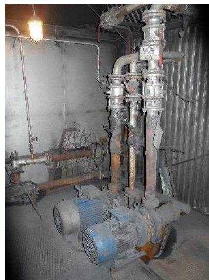
Рисунок 3.1.94 - Циркуляционные насосы типа КМ-80-50-200
