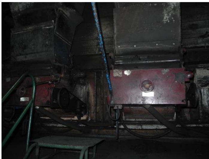
Рисунок 3.1.4 – Общий вид котла № 2.
