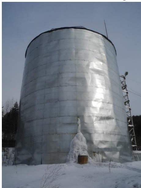
Рисунок 2.2.3 – Регулирующая емкость 1000 м 3
