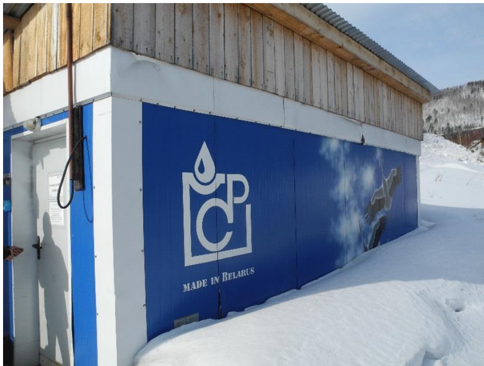
Рисунок 2.2.5 – Внешний вид здания фильтров
