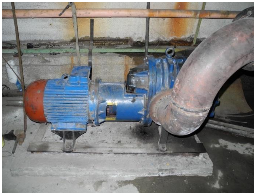
Рисунок 2.3.3 – Воздуходувки 32ВМФ-50-22,8-1,5-30
