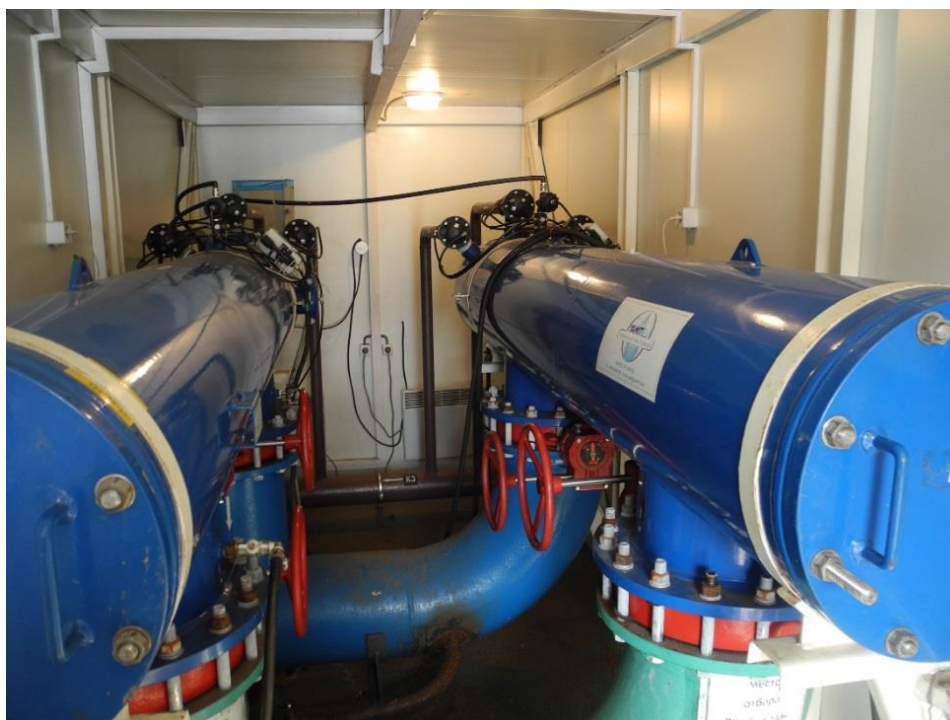
Рисунок 2.2.6 - Автоматические самоочищающиеся сетчатые фильтры «Yamit AF 814 PR»
