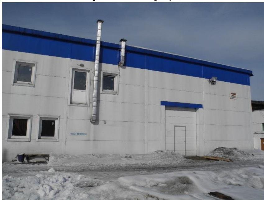
Рисунок 2.2.4 – Общий вид станции водоочистки
