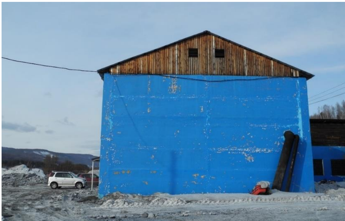
Рисунок 2.3.1 – Общий вид здания КОС
