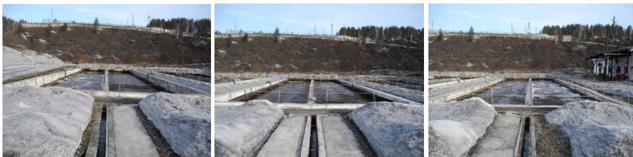
Рисунок 2.1.2 – Аэротенки очистных сооружений
