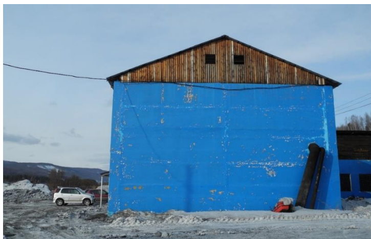
Рисунок 2.1.1 – Общий вид здания КОС
