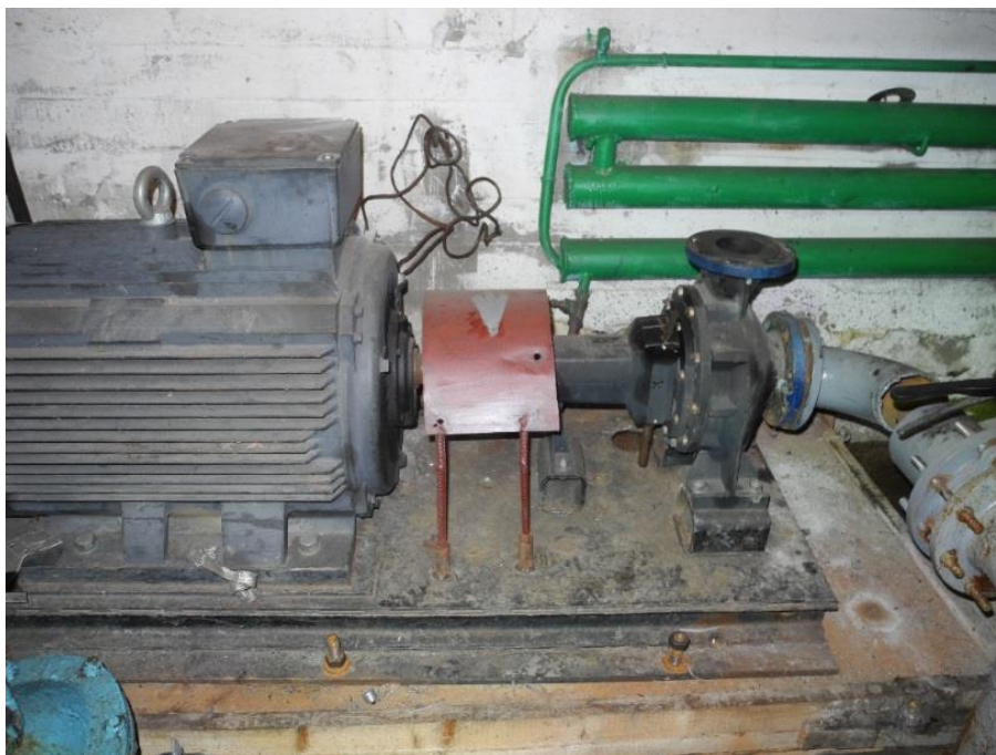
Рисунок 1.4.22 – Насос Grundfos NK 100-250/270
