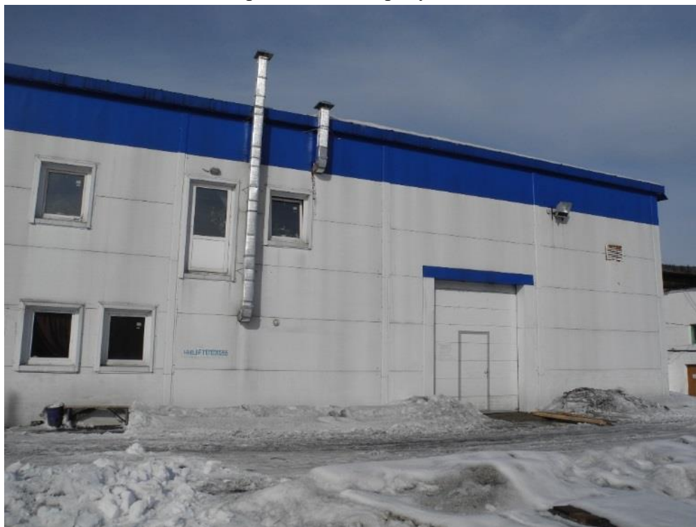
Рисунок 1.4.4 – Общий вид станции водоочистки
